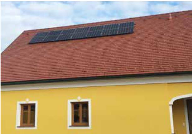
Abbildung 4: Musteranlage 2 Nachrüstung-PV-Anlage mit 3,78 kWp (01/2020)
