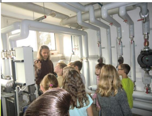
Besichtigung und Erklärung Heizungssystem in der Volksschule Lichendorf
